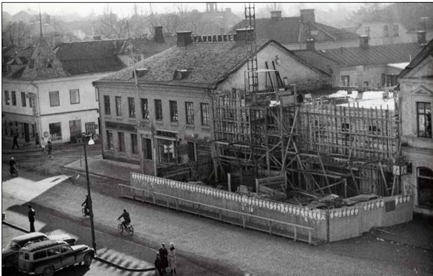
Nya Sparbanken under byggnation på Kungsgatan i Åmål bredvid gamla Sparbanken 1961.
