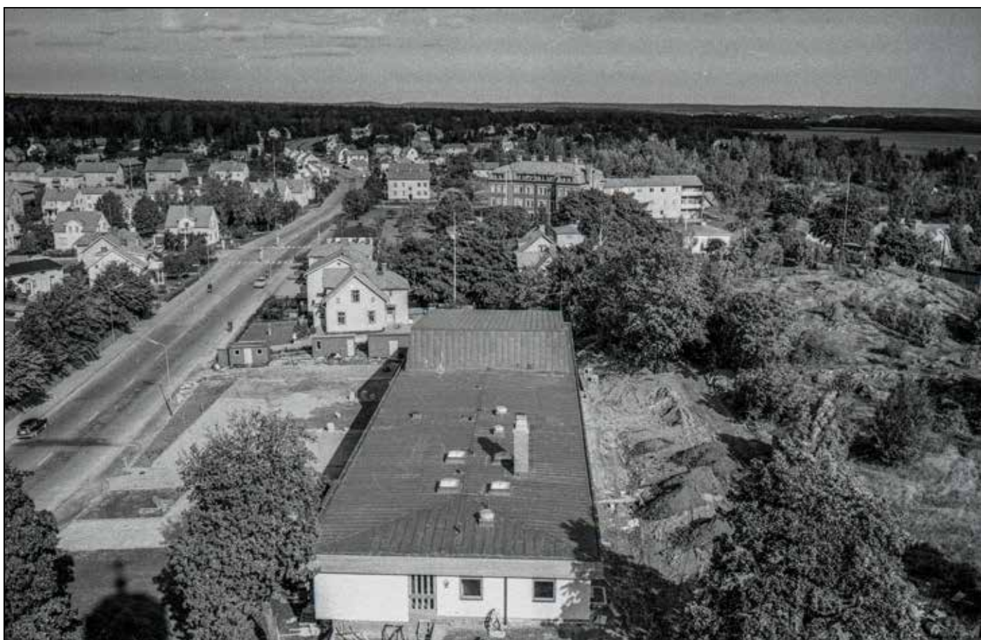
I förgrunden det nybyggda församlingshemmet som stod klart 1968. Lite längre bort ser man det gamla ålderdomshemmet. Hyreshusen på området bortanför ålderdomshemmet var inte byggda när foto togs..
