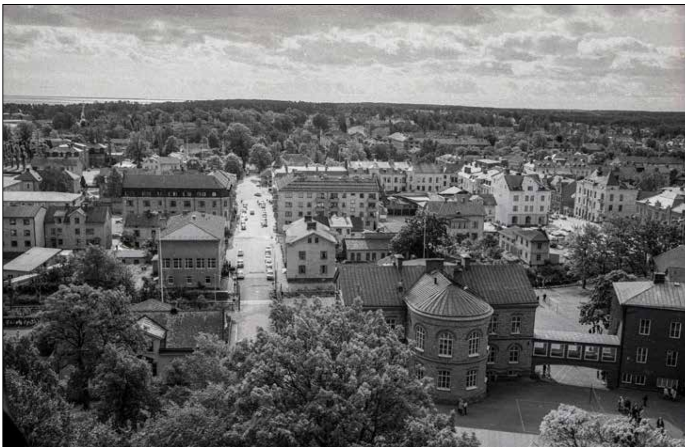
Bakom Norrtull ser man kvarteret längs Lunnegatan. Alla dessa gamla byggnader är rivna idag. Långt borta bredvid kommunhuset ser man taket på det gamla rådhuset där polisen höll till. Huset revs på sensommaren 1968.
