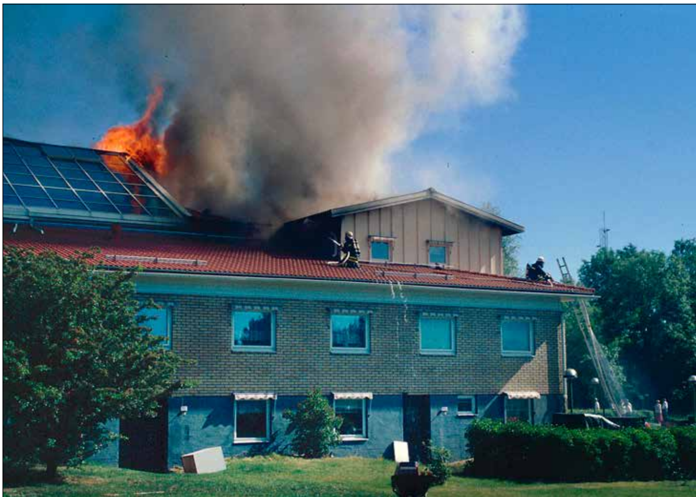
Solsätershemmet var i stort sett färdigrenoverat när branden bröt ut. Branden spred sig snabbt på vinden i fastigheten och var svårsläckt. Brandmännen kämpade länge för att få branden under kontroll och lyckades till slut. Solsäterhemmet fick stora men inte förödande skador och kunde återställas efter branden.
